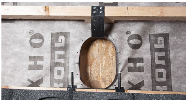
Рис. 39 а. Проходной элемент (UNIVERSAL) для панели Roman
